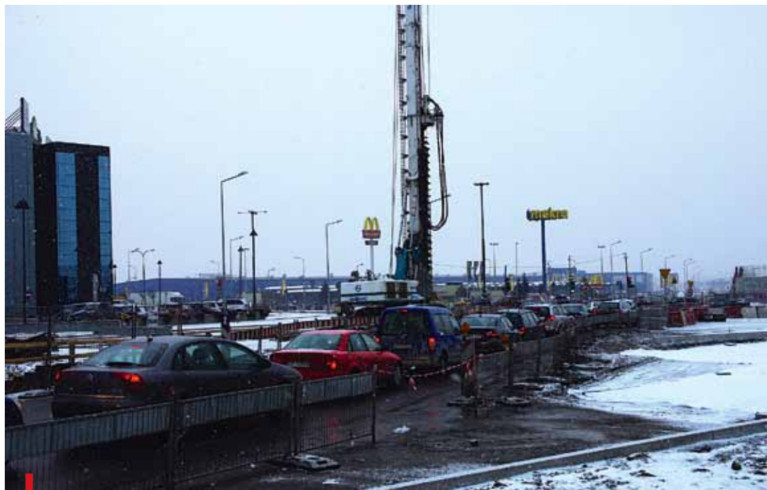
Remont ronda Ofiar Katynia skutecznie zakorkował znaczną część miasta. Być może budżet na 2011 r. pozwoli na zakończenie budowy i kierowcy odetchną z ulgą
