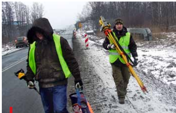
Na drodze w Schodni trwają prace od jesieni ubiegłego roku
