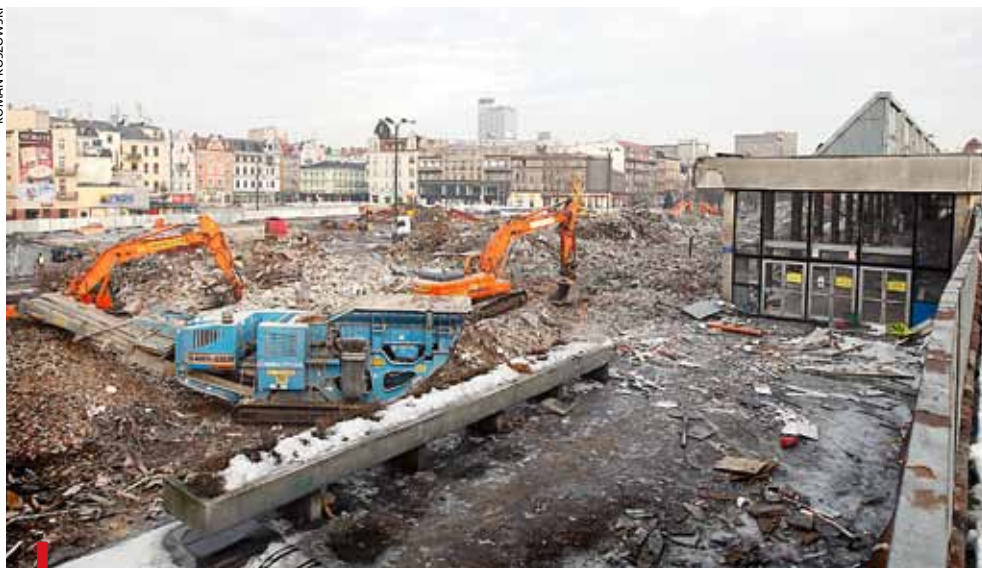
KATOWICE. 11 STYCZNIA 2011 R. Rozbiórka oddanej do użytku w 1972 r. hali głównej dworca PKP trwała zaledwie trzy tygodnie
