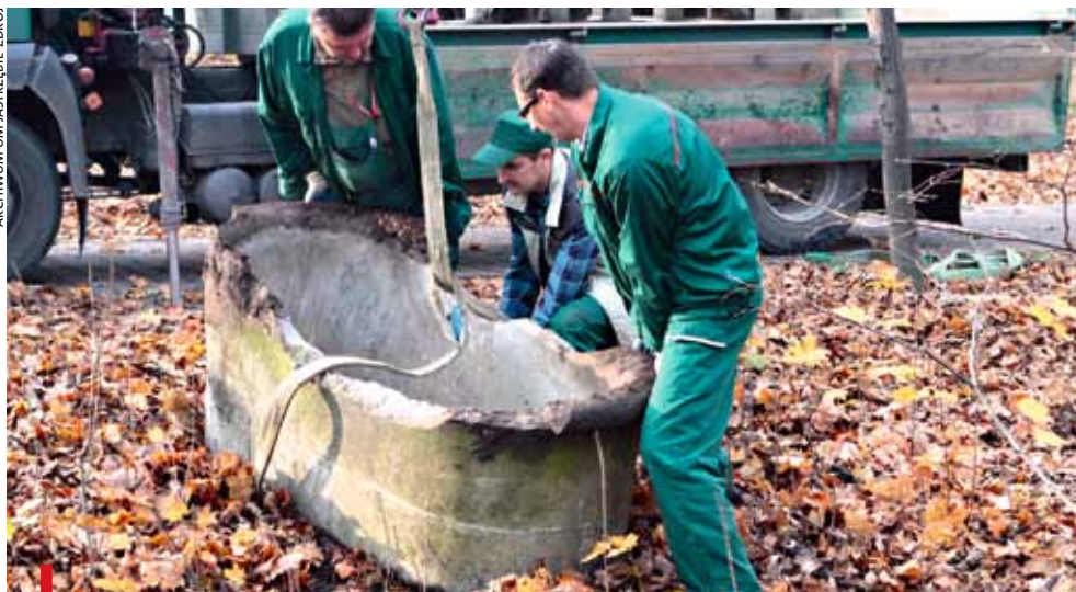
JASTRZĘBIE-ZDRÓJ. PARK ZDROJOWY. Podniesienie ok. 700-kilogramowej wanny wymagało wykorzystania dźwigu. Na zdjęciu pracownicy Jastrzębskiego Zakładu Komunalnego przygotowują zabytek do transportu
