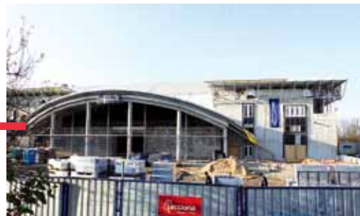
Nowa hala powstanie w miejscu starej, już rozebranej
