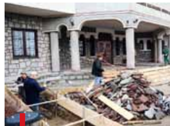
Z lewej strony schodów znajdzie się podjazd dla osób niepełnosprawnych
