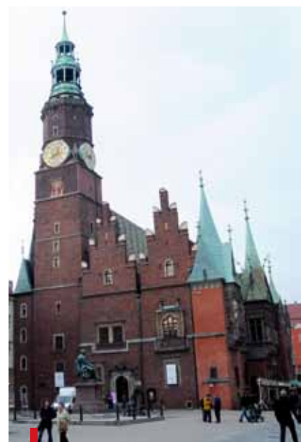
Najlepiej zachowane historyczne podziemia znajdują się w Ryнку. Pod ratuszem, w Piwnicy Świdnickiej, znajdziemy np. tunel prowadzący do dawnego składu piwa
