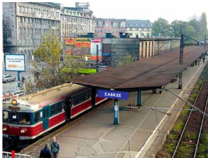
Na remont dworca mieszkańcy i podróżnicy czekają od wielu lat
