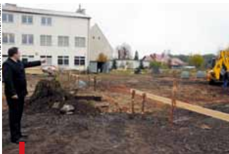
Dyrektor Grzegorz Pfeiffer wskazuje miejsce, gdzie ma stanąć hala sportowa
