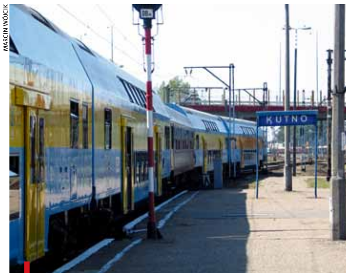
Kutno to dobre miejsce na budowę terminala przeładunkowego ze względu na trasę kolejową E-20 łączącą Moskwę, Warszawę i Berlin
