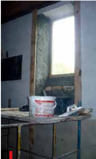
Podczas remontu przebudowano okna i niektóre ściany
