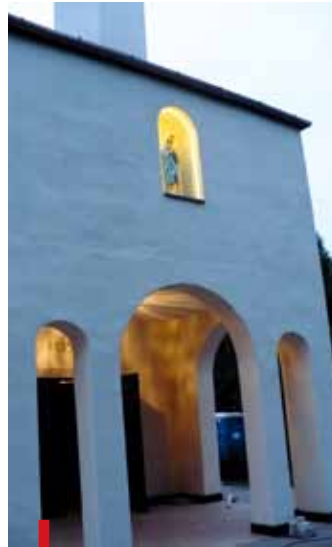
Prace objęły także elewację kościoła
