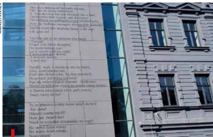
Fragment fasady nowej siedziby biblioteki miejskiej
