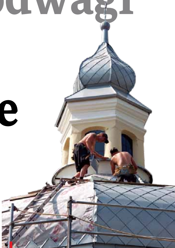
Pracownicy krakowskiego Krak-Investu kończą prace na dachu kaplicy Aniołów Stróżów
