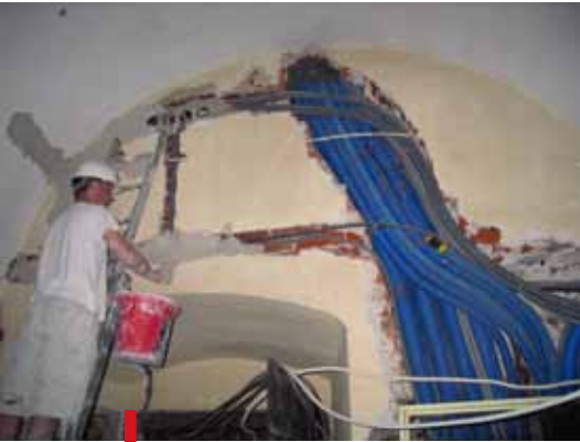
Krzysztof Rakoczy zajmuje się wymianą instalacji elektrycznej. Przyjechał do pracy w Łowiczu z okolic Krakowa
