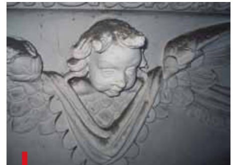
Każdy element na ścianie katedry zostanie odnowiony
