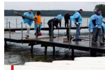
Na pomoście wymieniono spróchniałe deski. Pracy było naprawdę wiele
