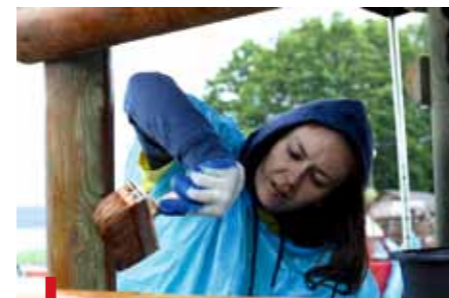
Każdy drewniany element został zabezpieczony bejcą
