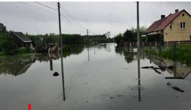
Już spokojne wody, tuż po przejściu fali kulminacyjnej na Odrze
