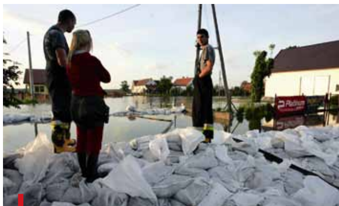
Chwila odpoczynku przy umacnianiu prowizorycznych wałów przeciwpowodziowych
