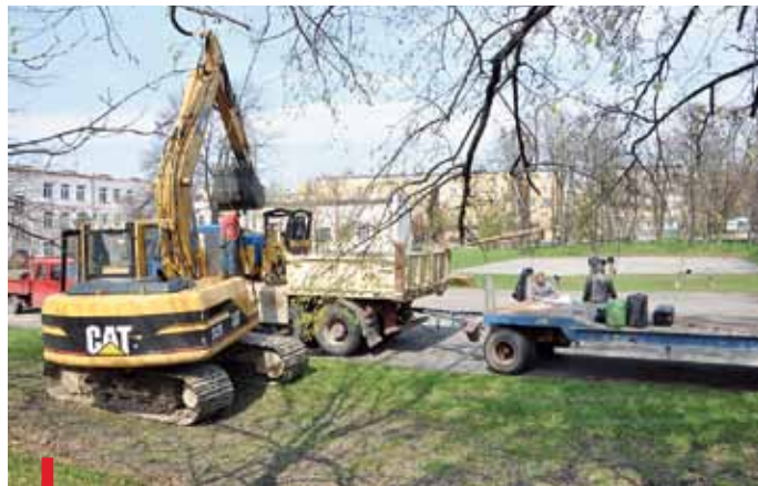
Prace budowlane na terenie szkoły rozpoczęły się 13 kwietnia
