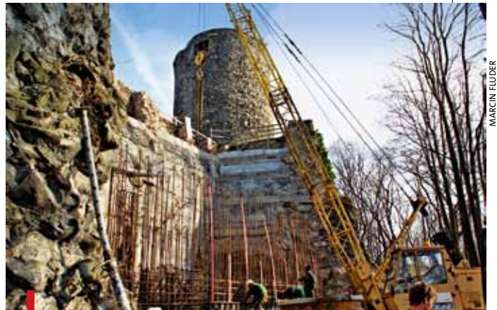
Fragment restaurowanych murów wleńskiej warowni. Betonowa plomba zostanie pokryta kamieniami
