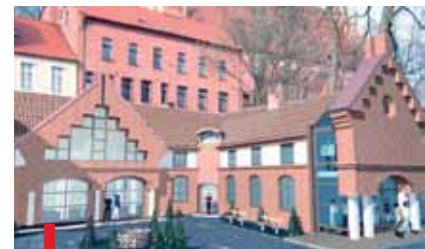
Tak wygląda projekt olsztyńskiego Centrum św. Jakuba, które miałoby powstać w tym miejscu OBOK: A tak w chwili obecnej wyglądają budynki u podmurza katedry
