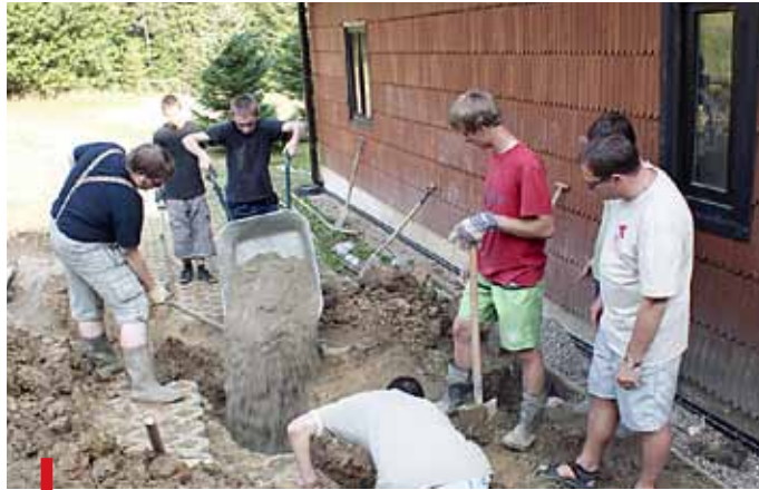
W domu kleryckim na Bobczonce każda grupa alumnów przeprowadza drobne remonty i prace
