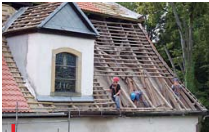
Prace na dachu świątyni rozpoczęto latem ub. roku
