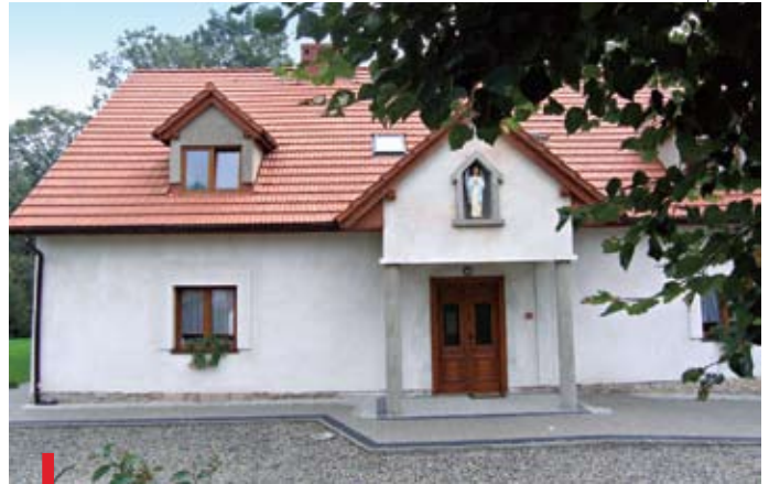
Odnowiona stara plebania w Pisarzowicach – z zewnątrz jeszcze surowa, w środku już działa kolorowe przedszkole
