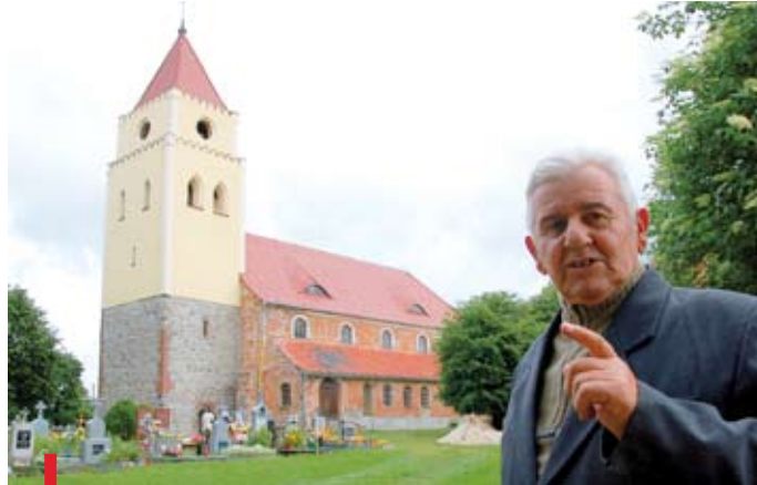
Wspólnie wyremontowaliśmy wieżę, dach, a teraz robiona jest elewacja. Pozostał jeszcze remont wnętrza świątyni – mówi Jan Korba z Janiszowic
