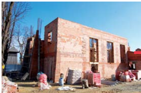
Mury nowego kościoła osiągnęły już poziom dachu
