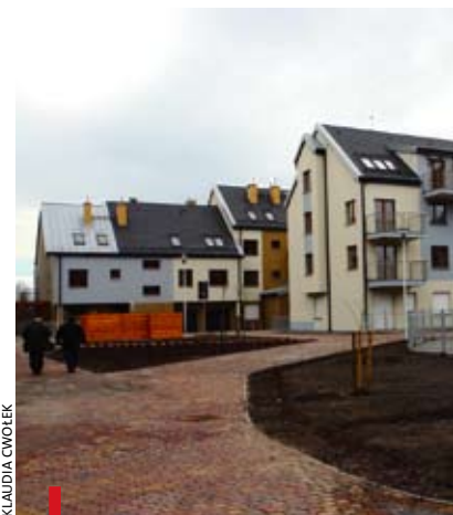
Nowe TBS-y przy ulicy Granicznej w Gliwicach
