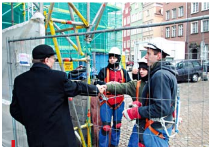
Ks. Stanisław Bogdanowicz wita przed wejściem ekipę, wykonującą prace wysokościowe
