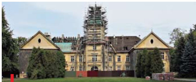
Remont dachu dzikowskiego zamku zostanie ukończony jeszcze w tym roku
