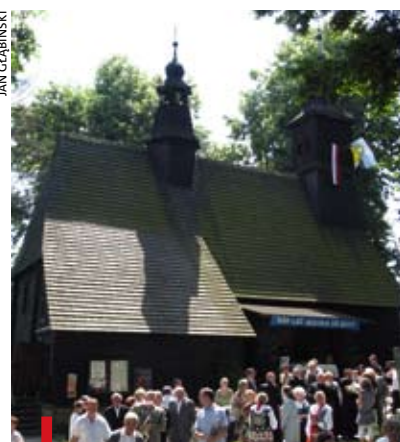
Kościół św. Anny będzie wkrótce chroniony systemem przeciwpożarowym „Tarcza”
