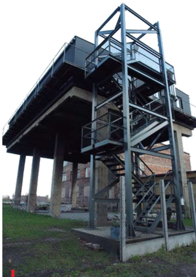
Bytomski Bołko-loft wznosi się na ośmiu słupach ponad ziemię na wysokość ponad 8 m
