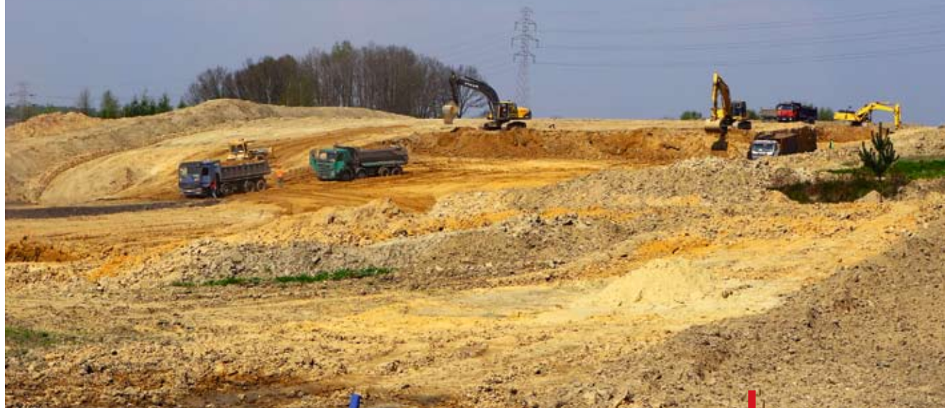
Budowa południowego odcinka A1. NA ZDJĘCIU roboty w okolicy Świerklan
