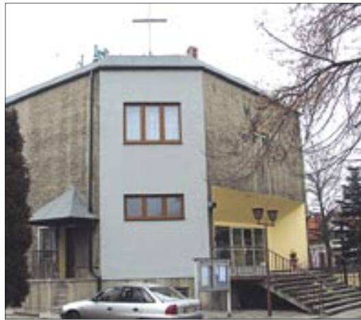
Z zewnątrz budynek wcale nie przypomina kościoła
