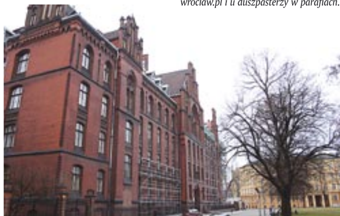
Budynek MWSW we Wrocławiu
