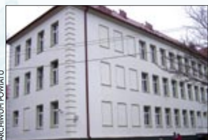
Remontowany budynek doczekał się także nowej elewacji
