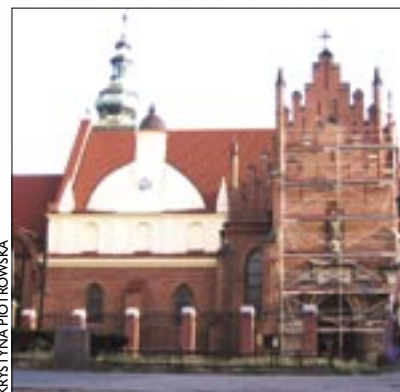
Fasada kościoła w trakcie prac konserwatorskich
