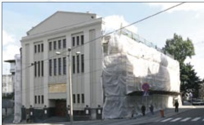
Trwa remont Kinoteatru Rialto
