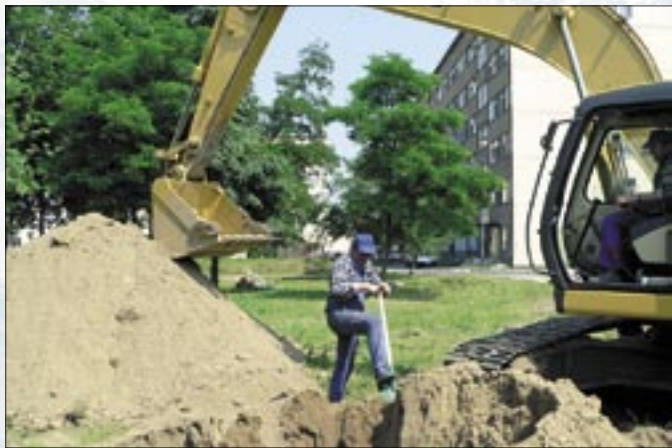
Ruszyła budowa nowego pawilonu szpitala w Stalowej Woli
