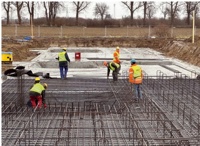
▲ Pod pierwszy dom wylewany jest właśnie fundament.
