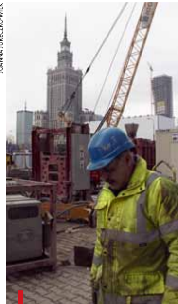
Prace przy budowie metra wkroczyły w fazę najbardziej uciążliwą dla mieszkańców
