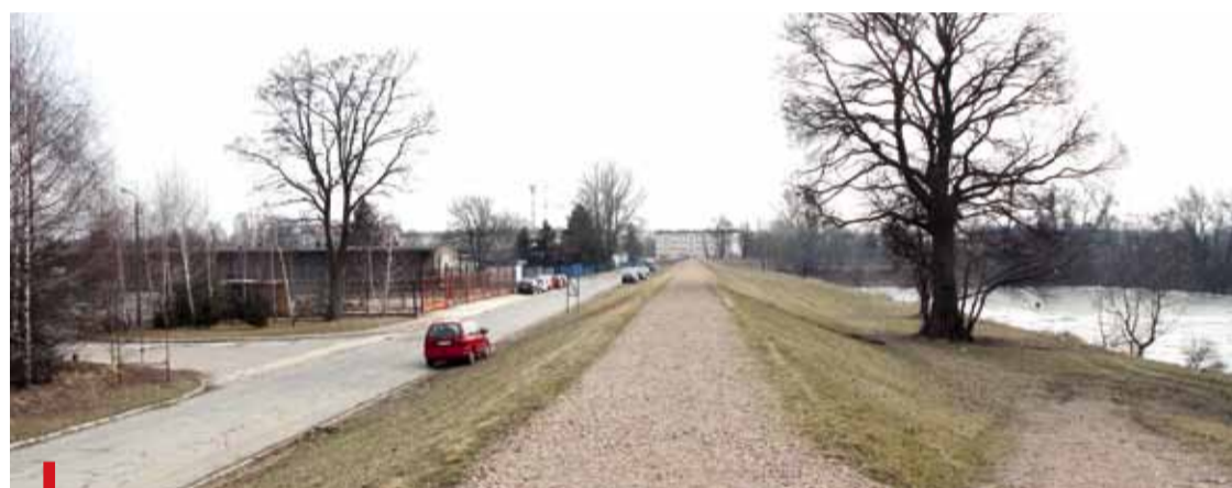
Marzec 2012 r. Wał przy ul. Na Zakołu Wisły jest już naprawiony
