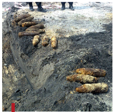
Pociski artyleryjskie znalezione na budowie stacji Stadion
