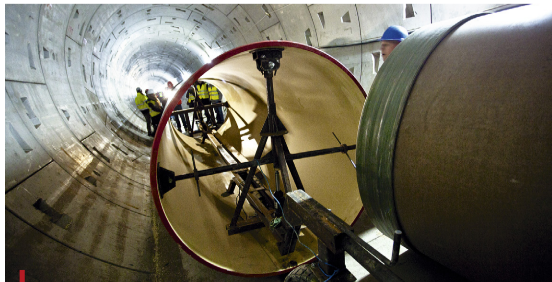
1300 m tunelu pod dnem rzeki to pierwsza tego rodzaju inwestycja w Polsce. Tarcza TBM drążyła dziennie od 8 do 25 m wykopu.
