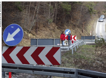
Osuwiska niemal zniszczyły całkowicie drogę ku przejściu granicznemu w Mniszku
