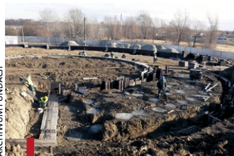
Na placu budowy widać już zarysy hospicjum
