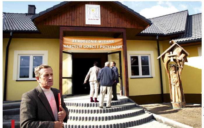
Dom „Razem” z zewnątrz jest prawie gotowy
