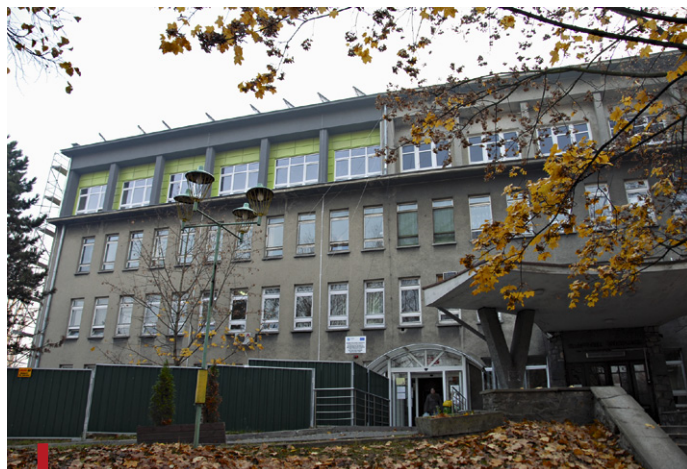
Na skierniewickim szpitalu zamontowane zostały kolektory słoneczne
