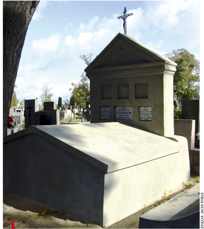
Grobowiec Walentego Lilienheima i dwóch Marii Sienkiewiczowych przed i po remoncie
