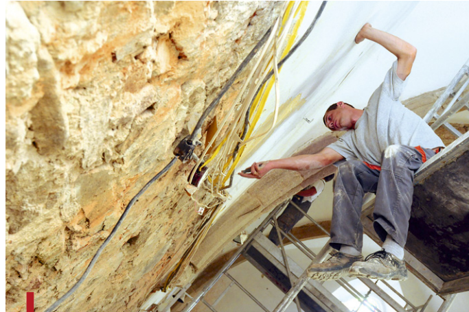
Remont ścian odsłonił ubytki i odkształcenia kościelnego sklepienia w Witoszowie
