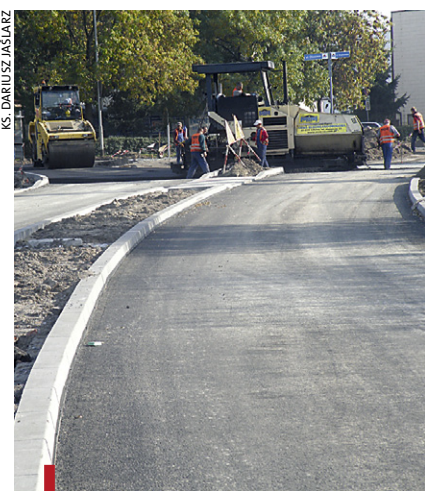
Prace przy drugim etapie budowy idą pełną parą
