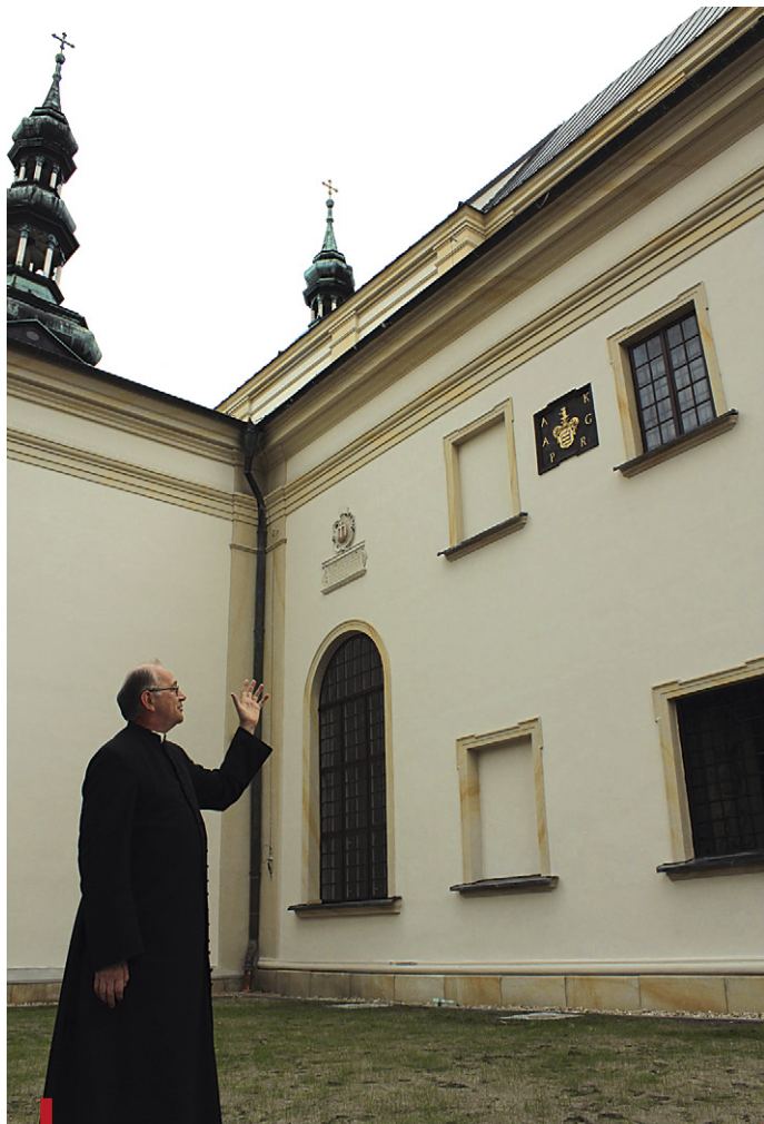
Probszcz ks. Wiesław Skonieczny podkreśla, że bez pieniędzy unijnych nigdy nie udałooby się w tak krótkim czasie dokonać kompleksowego remontu katedry
