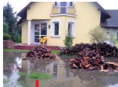
Teraz już nawet niewielkie opady skutkują podtopieniami
